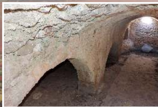
Εσωτερικό θολωτής δεξαμενής
